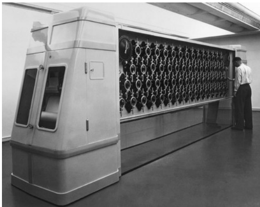
Abbildung: Gezeitenrechenmaschine im Deutschen Museum, gebaut 1935-39. (Quelle: Deutsches Museum)
